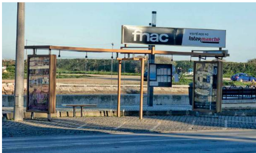
Paragem rodoviária na Avenida dos Descobrimentos - Lagos (Janeiro 2021)
