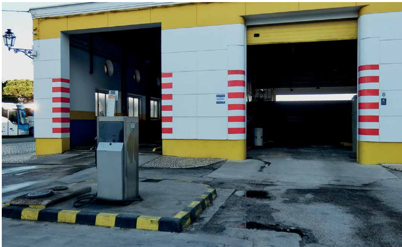
Interior da zona de manutenção do terminal rodoviário de Lagos, Rossio de São João (Janeiro de 2021)
