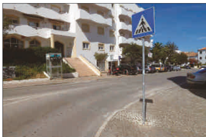
Passadeira por pintar - Rua das Juntas - Lagos
